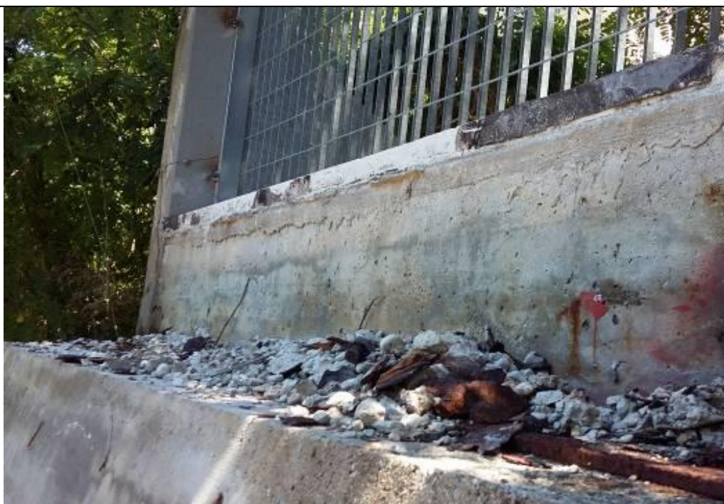
Foto 16: Spalla Nord (particolare) zona appoggi
