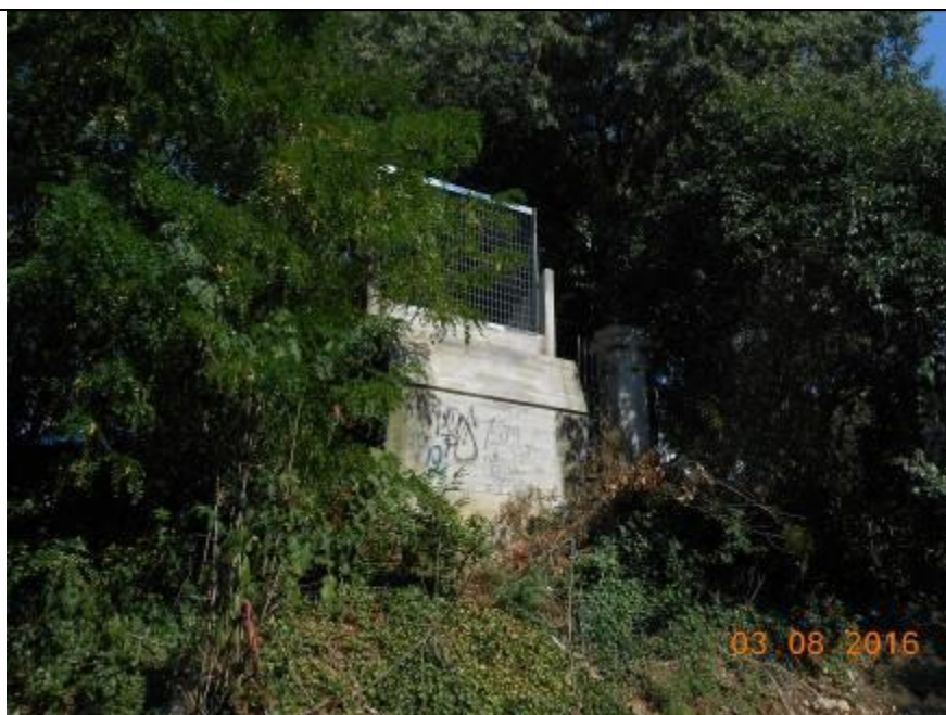
Foto 10: Spalla lato Nord
