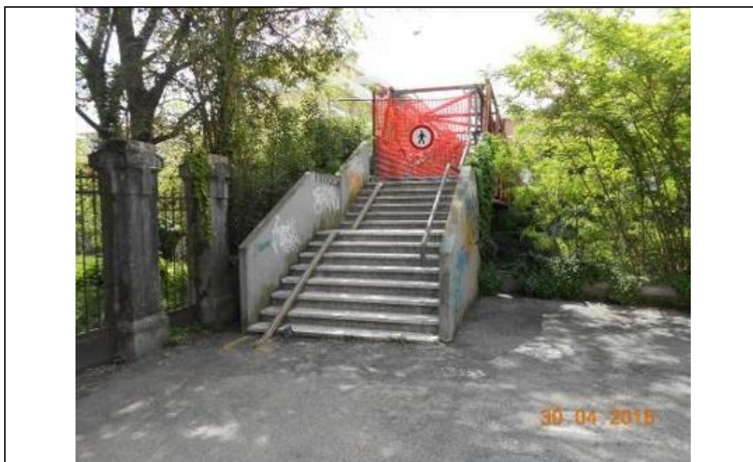
Foto 7: Accesso alla passerella (via Piave)
