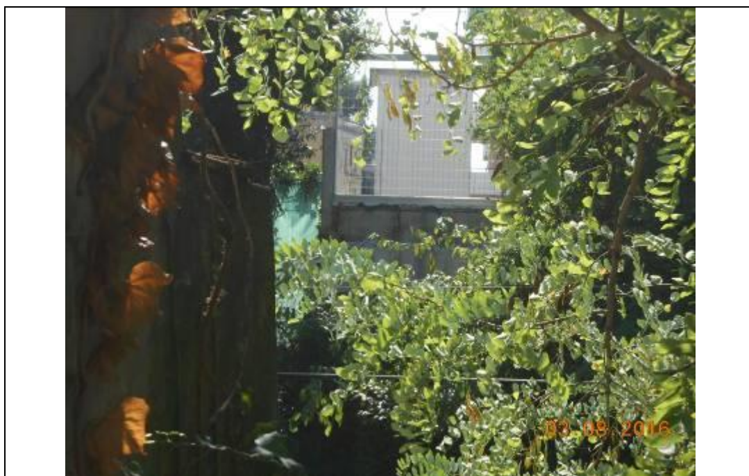
Foto 3: Spalla passerella lato Sud
