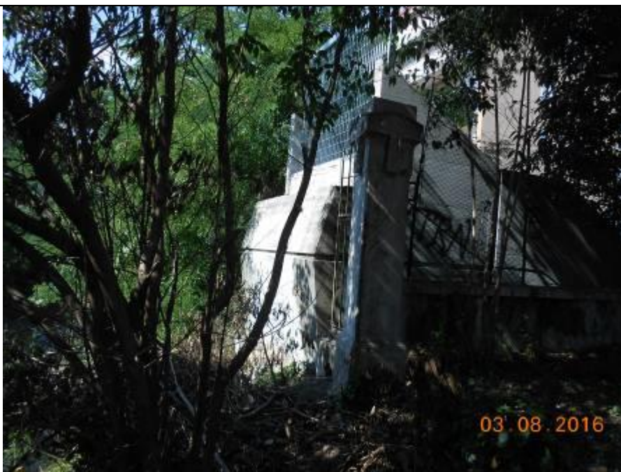
Foto 9: Spalla lato Nord
