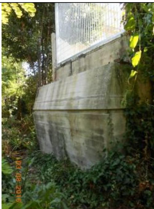
Foto 5: Particolare Spalla Sud
