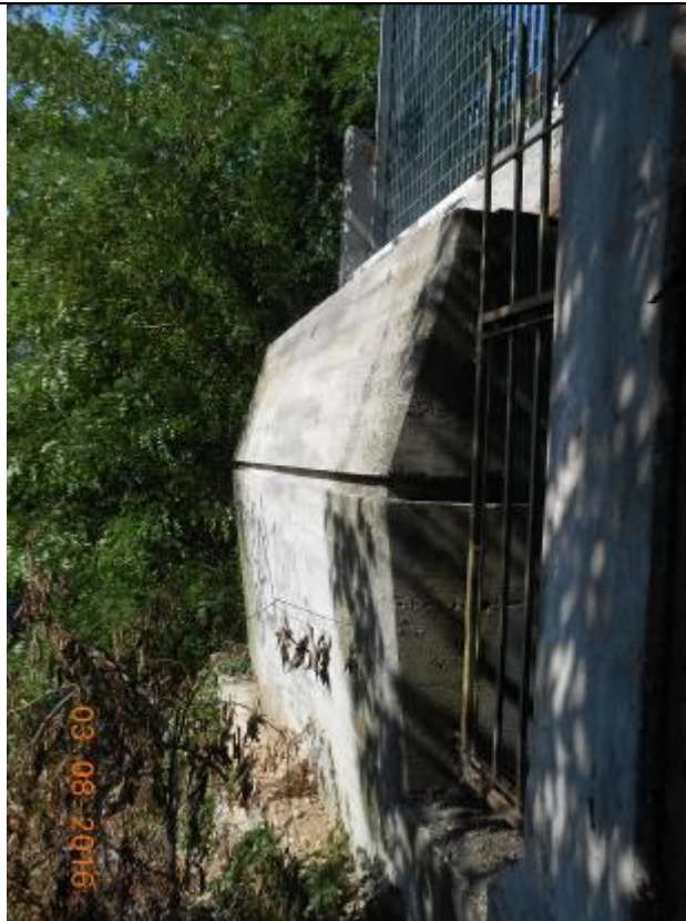
Foto 12: Spalla Nord (particolare)
