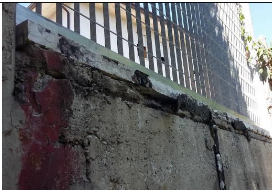
Foto 14: Spalla Nord (particolare)
