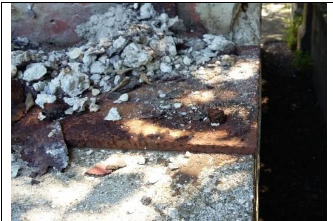
Foto 15: Particolare Appoggi fissi Spalla Nord
