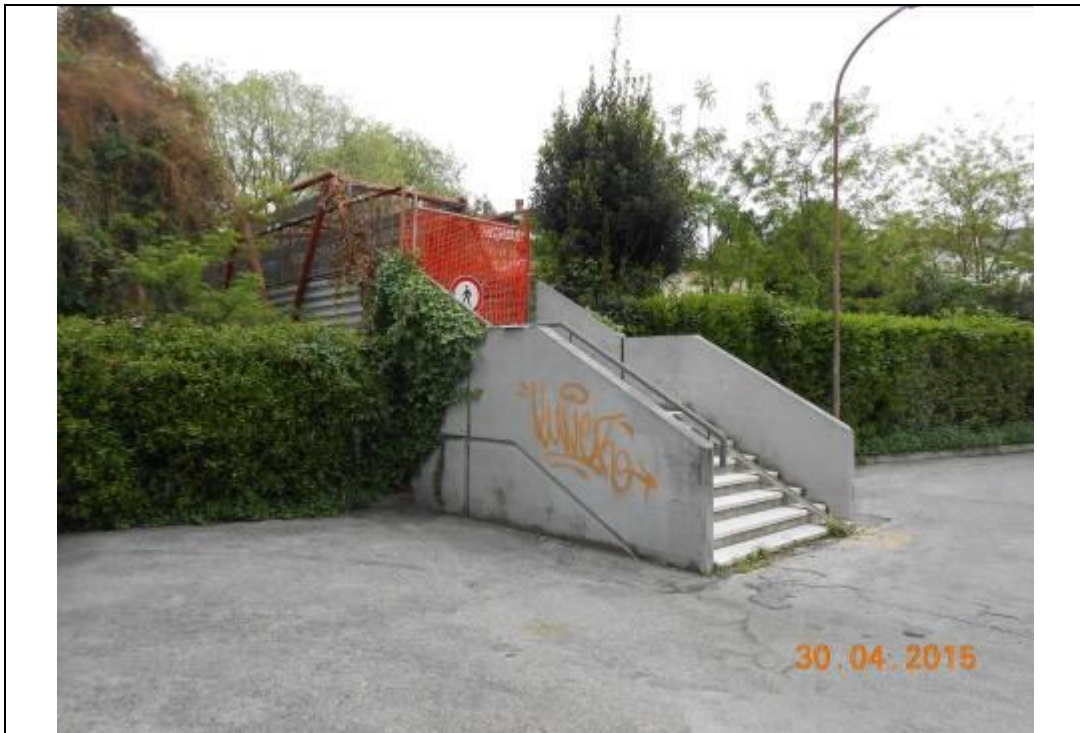
Foto 1: Accesso alla passerella lato via Torino
